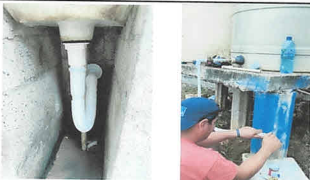
Foto 5: Se trabajo en la reparación de los sanitarios existentes para dejarlos funcionando y se instaló un nuevo tinaco o tanque de almacenamiento de agua de 1,100 litros
