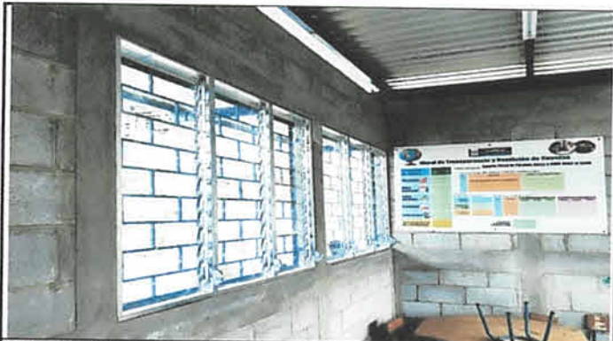
Foto 3: Se instalaron ventanas tipo celosía o de paleta de vidrio claro y marco de aluminio para mantener la mayor cantidad de ventilación e iluminación posible.
