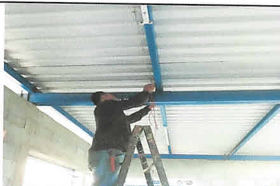
Foto 4: Se Cableo e instalaron lamparas y tomacorrientes desde el tablero de flipones.
