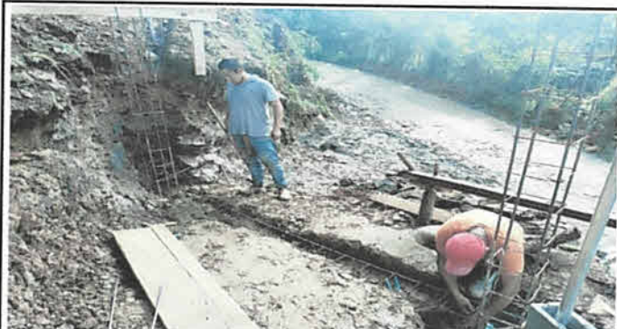
Foto 6: Para la colocación del portón de ingreso se fundieron columnas que servirán de apoyo para soprt y funcionamiento del portón de malla
