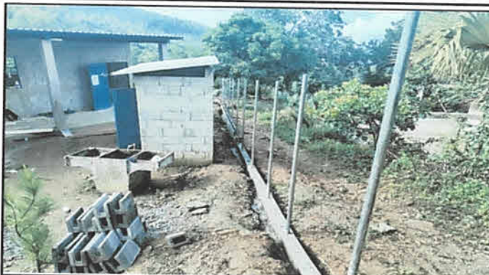
Foto 2: Luego de la cimentación se colocó la plantilla de una hilada de block para posteriormente colocar la solera tipo U en donde irá sujeta la malla
