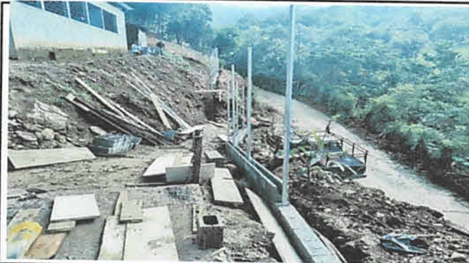
Foto 1: Para la circulación con malla se zanjeo para fundir cimiento corrido, fundiendo los postes de tubo galvanizado desde el suelo para dar mayor solidez a la circulación
